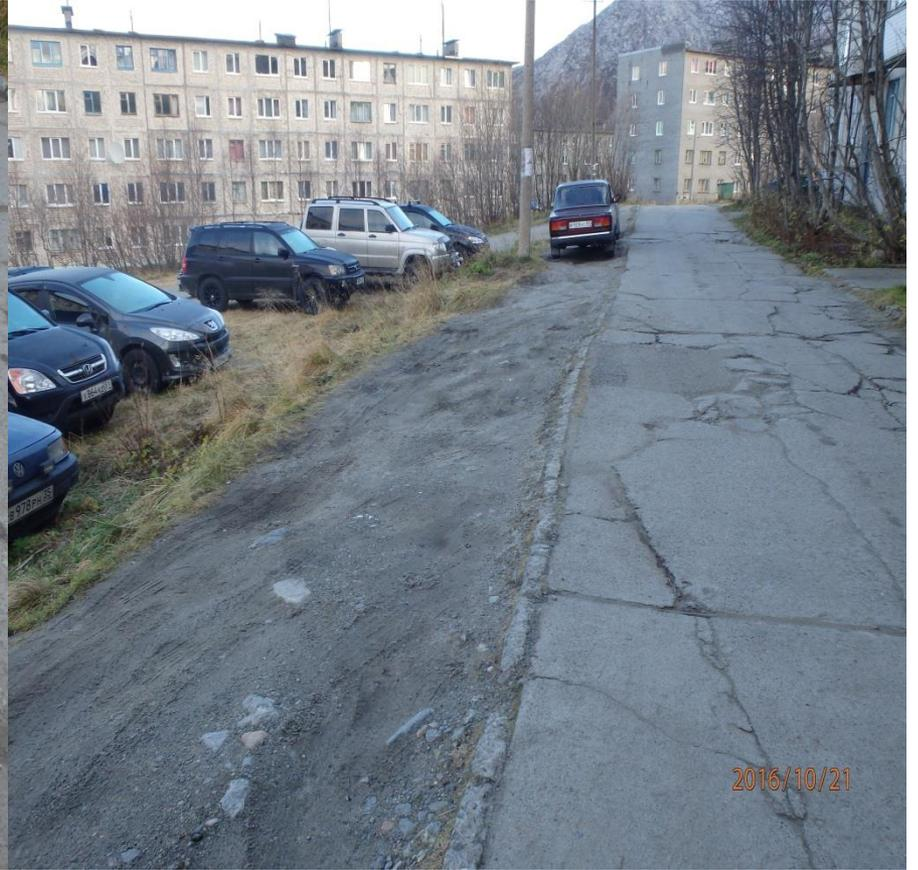
*Также возле входных групп либо отсутствуют скамейки и урны, либо установлены морально устаревшие. Основание подходов к крыльцам – цементобетонное, имеющее признаки изношенности. На поверхности наблюдается значительная сеть волосяных трещин в раскрытии, выше допустимой, местные просадки и разрушение материала покрытия.*
