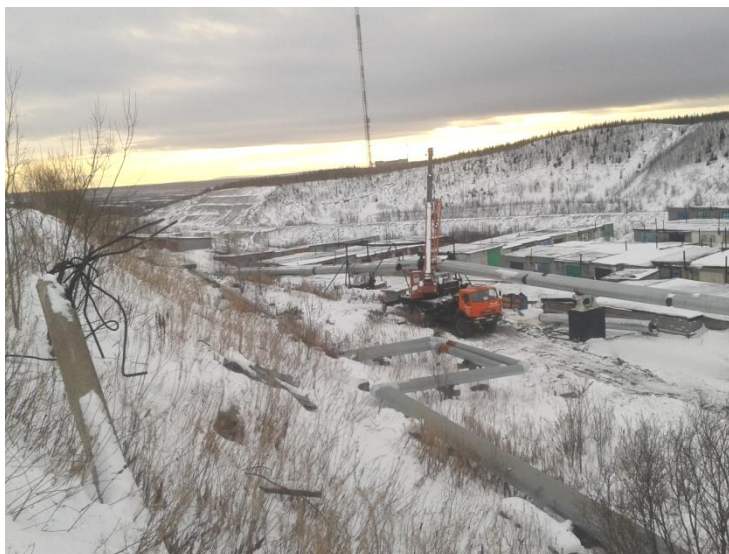
Рисунок 1.3 Строительство тепломагистрали между ТНС-3а и ПНС.
