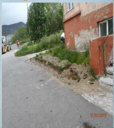
Выполнено устройство траншеи под установку бортового камня
