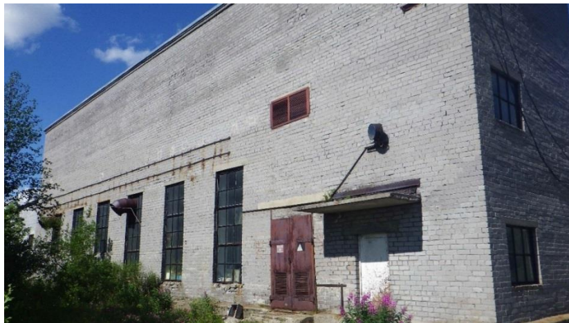
Рисунок 6. Насосная станция 2-го подъема на водозаборе «Центральный»
