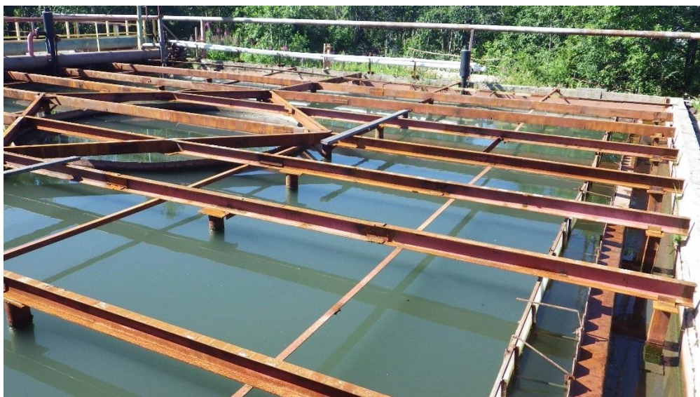
Рисунок 30. Аэротенки КОС №4
