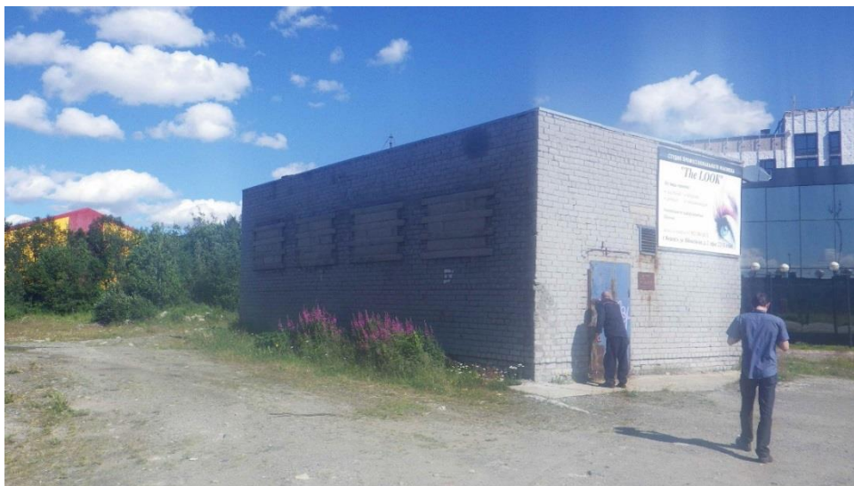
Рисунок 10. Насосная станция 3-го подъема для подачи воды в 11 микрорайон.
