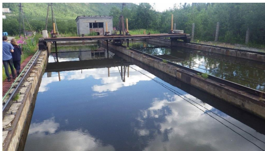
Рисунок 24. Вторичный отстойник КОС №2.
