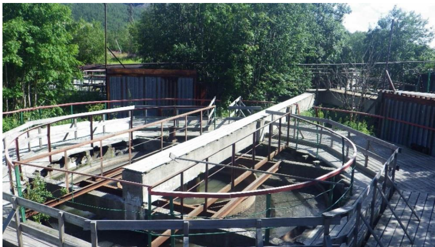
Рисунок 22. Осветлитель-перегниватель КОС №2.
