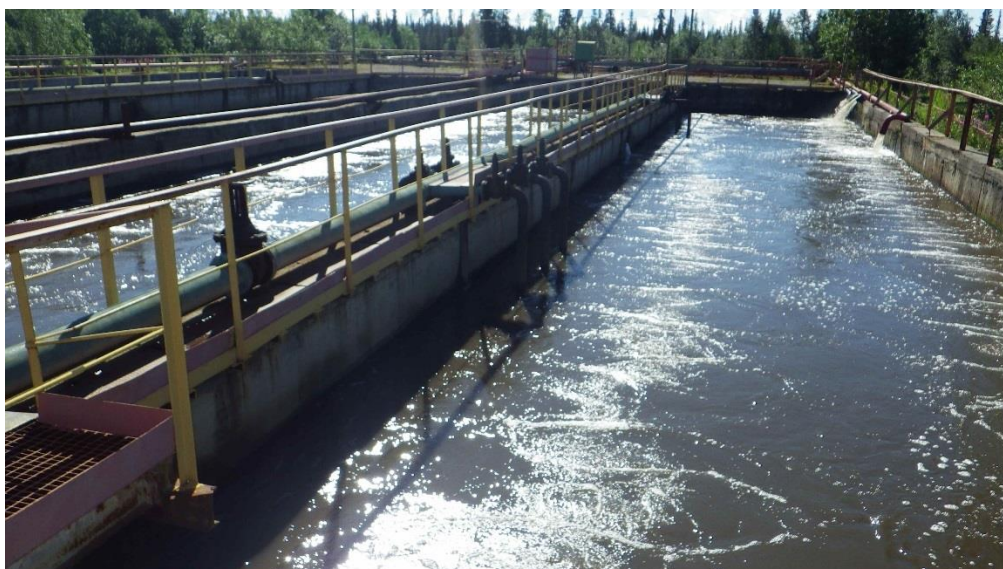
Рисунок 31. Вторичные отстойники КОС №4
