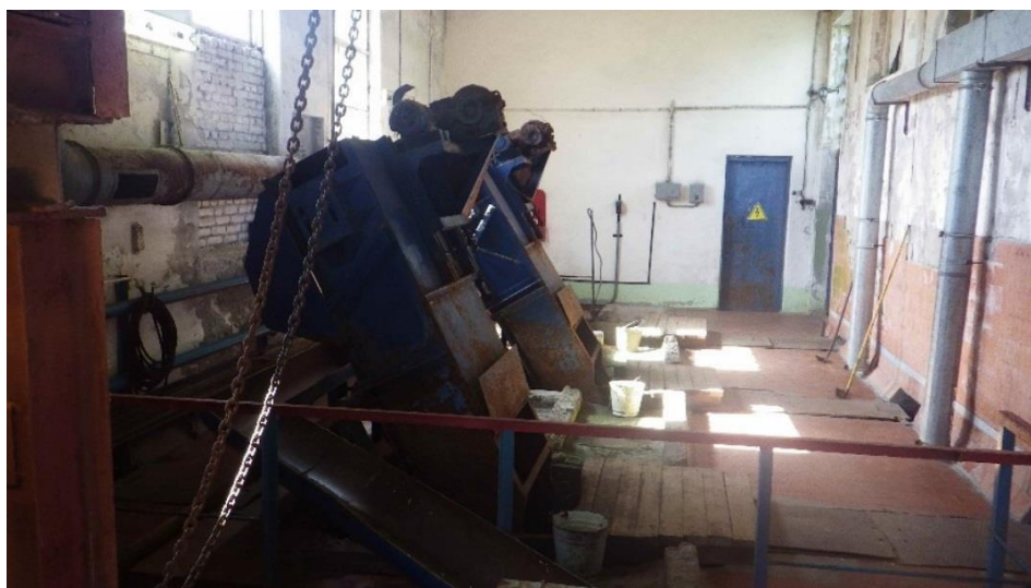
Рисунок 20. Решетки и дробилки КОС №2.
