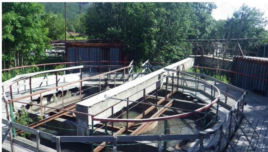
Рисунок 22. Осветлитель-перегниватель КОС №2.
