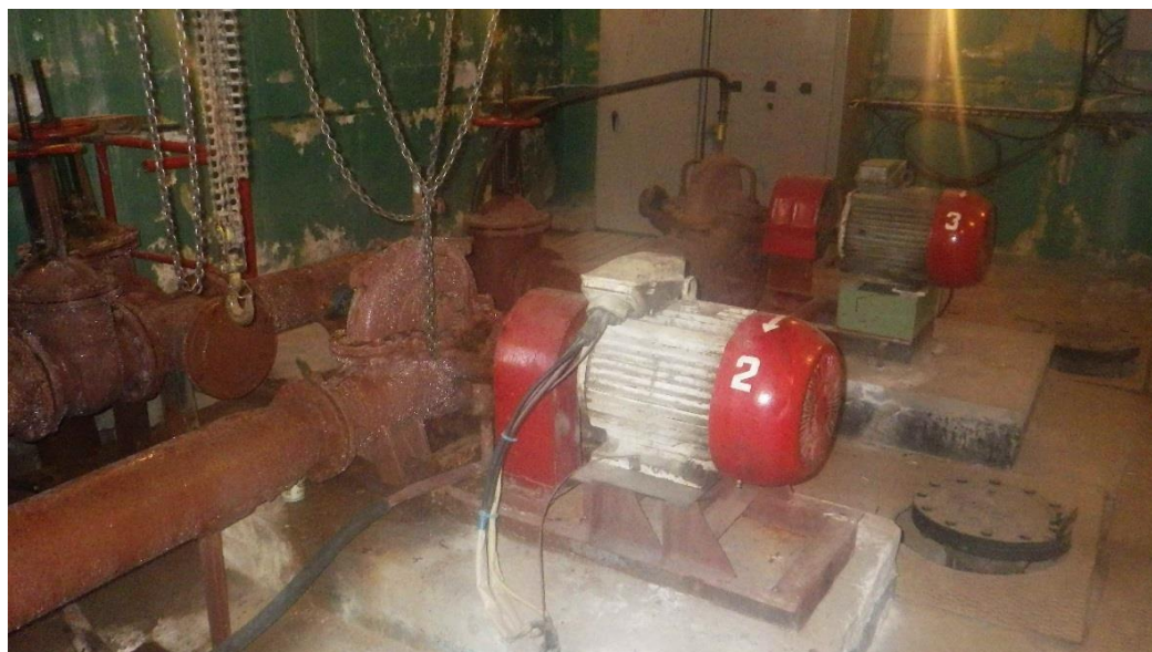
Рисунок 9. Насосное оборудование НС-3 для подачи воды в квартал 3/8.
