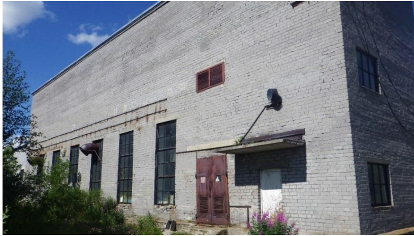
Рисунок 6. Насосная станция 2-го подъема на водозаборе «Центральный»
